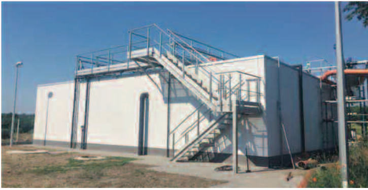
Oczyszczalnia ścieków Świdnica
