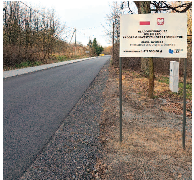
Budowa ul. Długiej w Świdnicy
