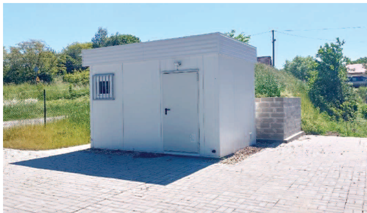
Budowa zbiornika pośredniego i stacji podnoszenia ciśnienia w Wilkanowie – etap II
