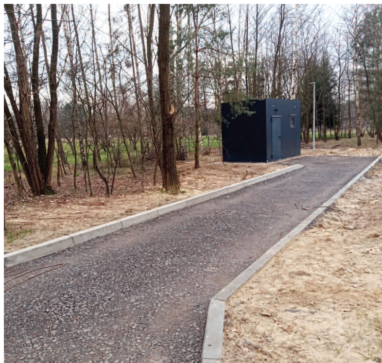
Nowa stacja podnoszenia ciśnienia w Słone
